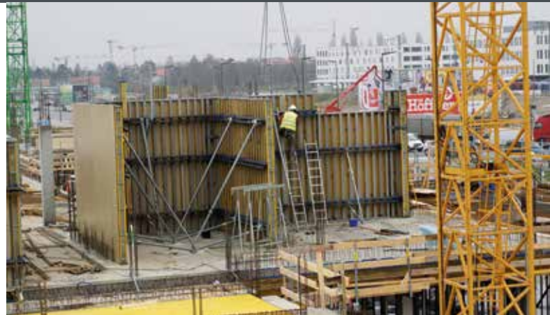
Westaspan 450 MF XXL auf Doka-Systemschalung im Einsatz.
