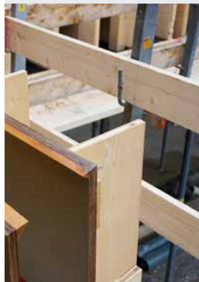
Konfektionierte Schalung kommt für die Brüstung der Balkonelemente zum Einsatz.
