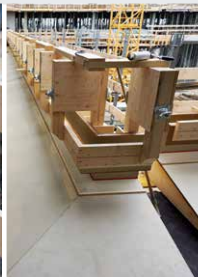
Konfektionierte Schalung kommt für die Brüstung der Balkonelemente zum Einsatz.
