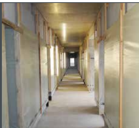
Vorbildlicher Sichtbetonschutz
