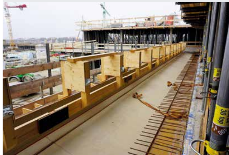
Konfektionierte Schalung kommt für die Brüstung der Balkonelemente zum Einsatz.
