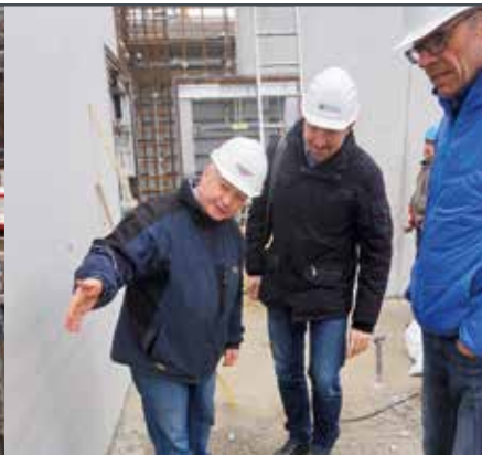
Bauleiter Stefan Wallner (links) lobt die sauberen Oberflächen und das exakte Schalbild beim Rundgang mit Dipl.-Ing. Alfred Floßmann (rechts) und Westag-Gebietsleiter Michael Hörmann.
